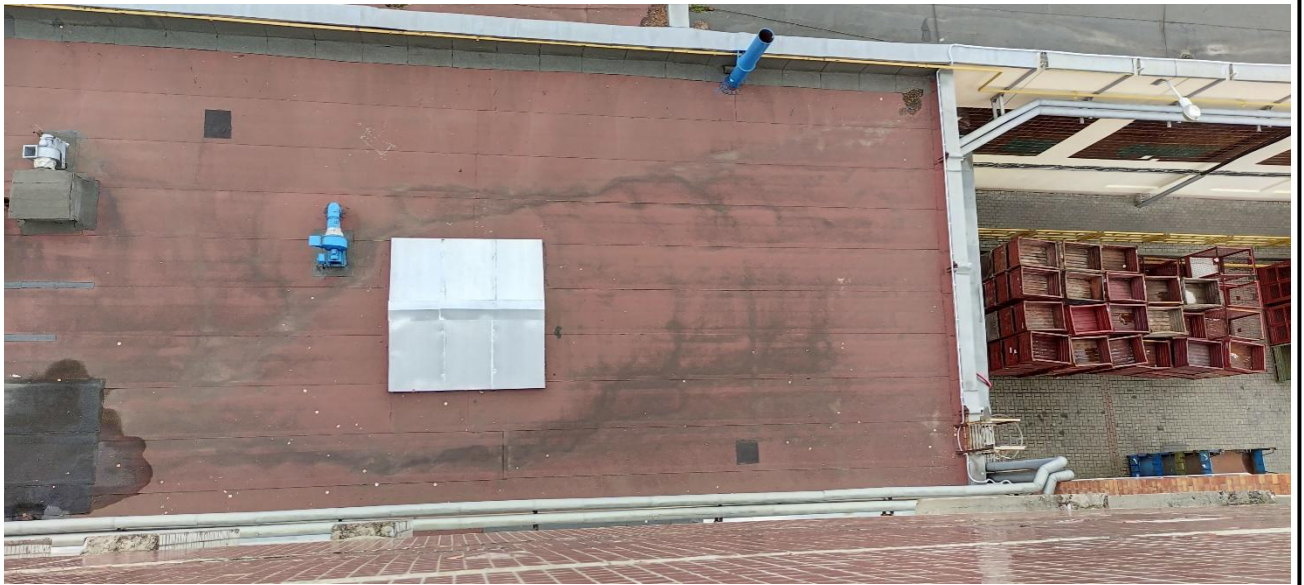
Кровля АБК (часть 2).
