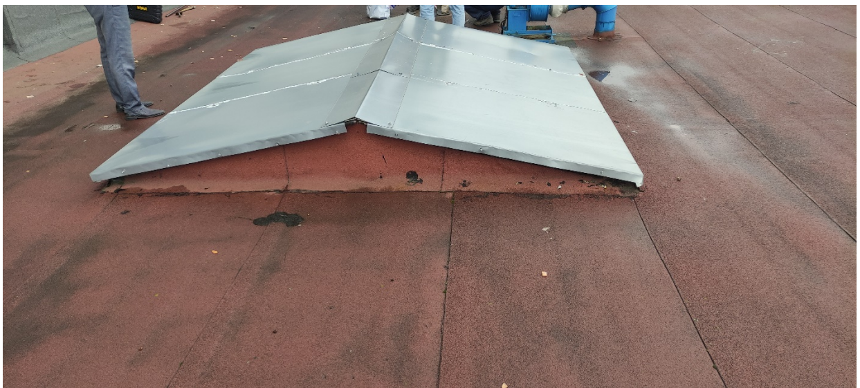
Зенитный фонарь на кровле АБК закрыт фартуком.
