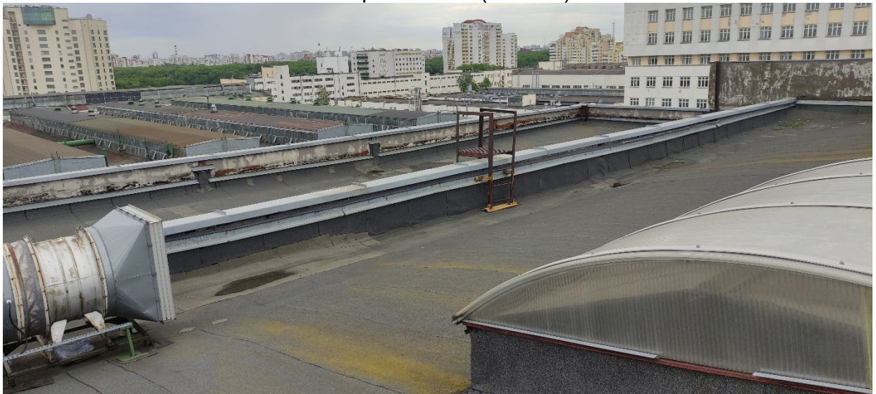
Кровля в осях Л/1-И
