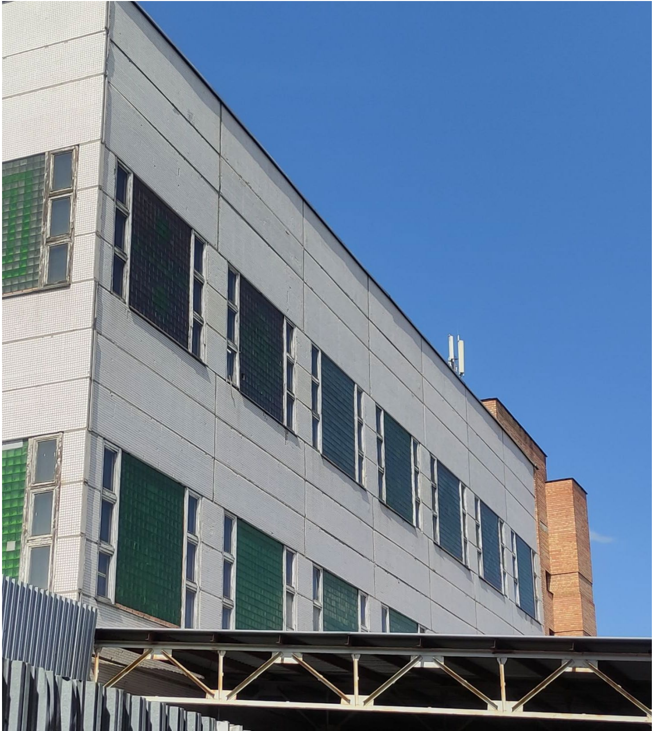
Часть фасада в осях Л/120-13.
